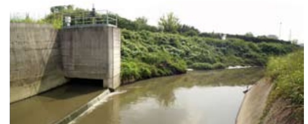
Punto in cui il Canale Fossetta confluisce allo scoperto nel Canale Roncajette Fossetta River emerges from a pipe beneath North ZIP and flows into public space
