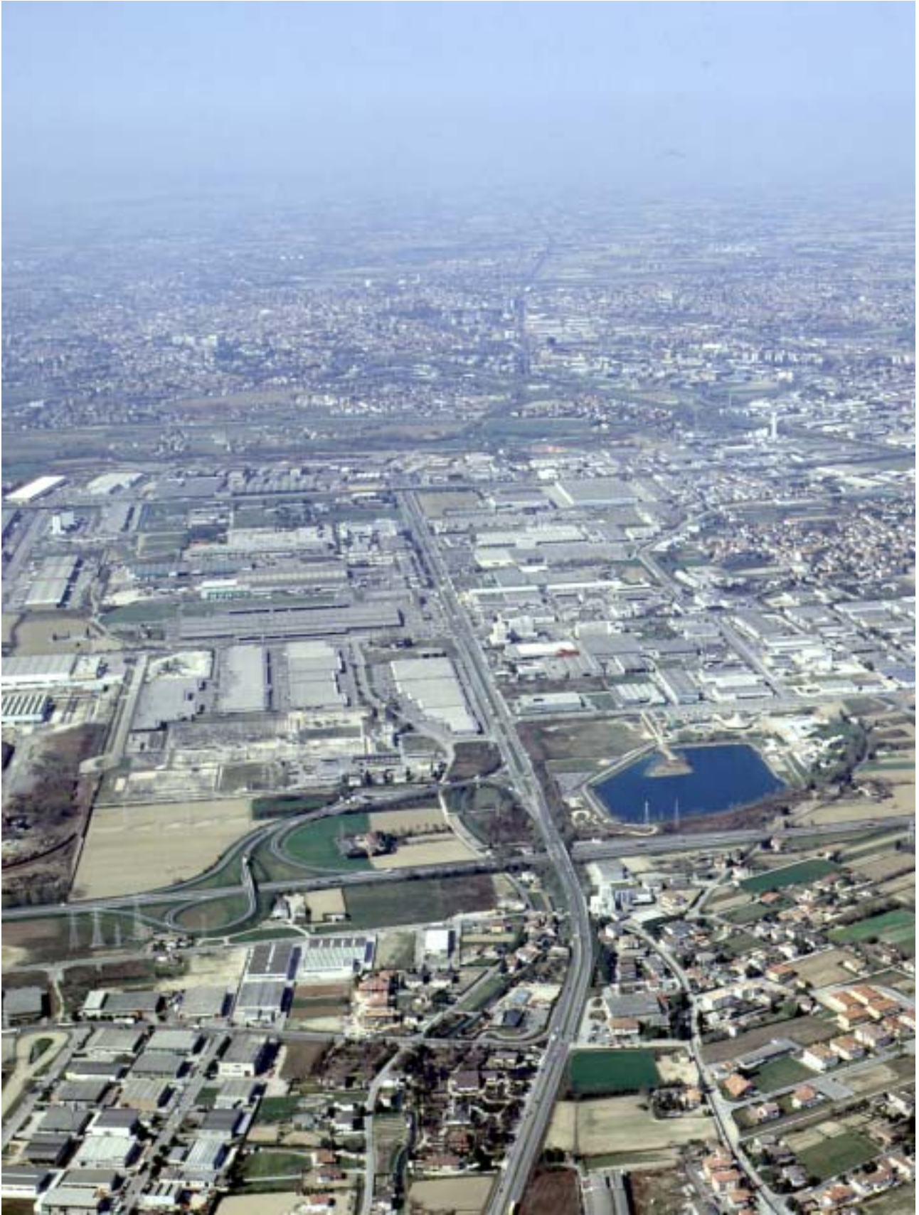
(fig. 1) FOTO AEREA DELLO SVINCOLO AUTOSTRADALE (A13) CON LA ZONA INDUSTRIALE DI PADOVA
